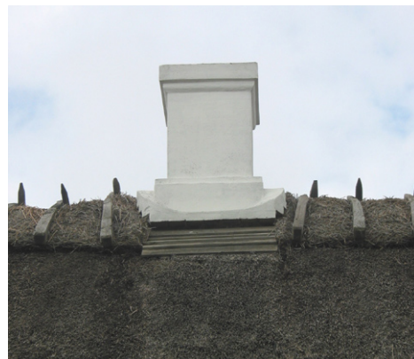
Skorstene kan eksempelvis genanvendes til udluftning
